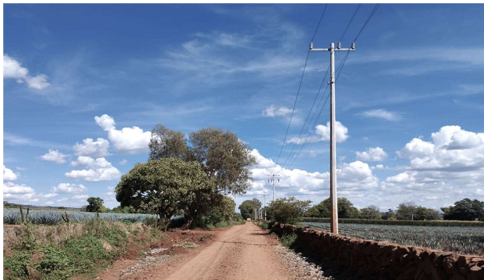
Fig. 68- Foto de Camino, Electrificación y Alumbrado del área de aplicación-Fuente Propia
