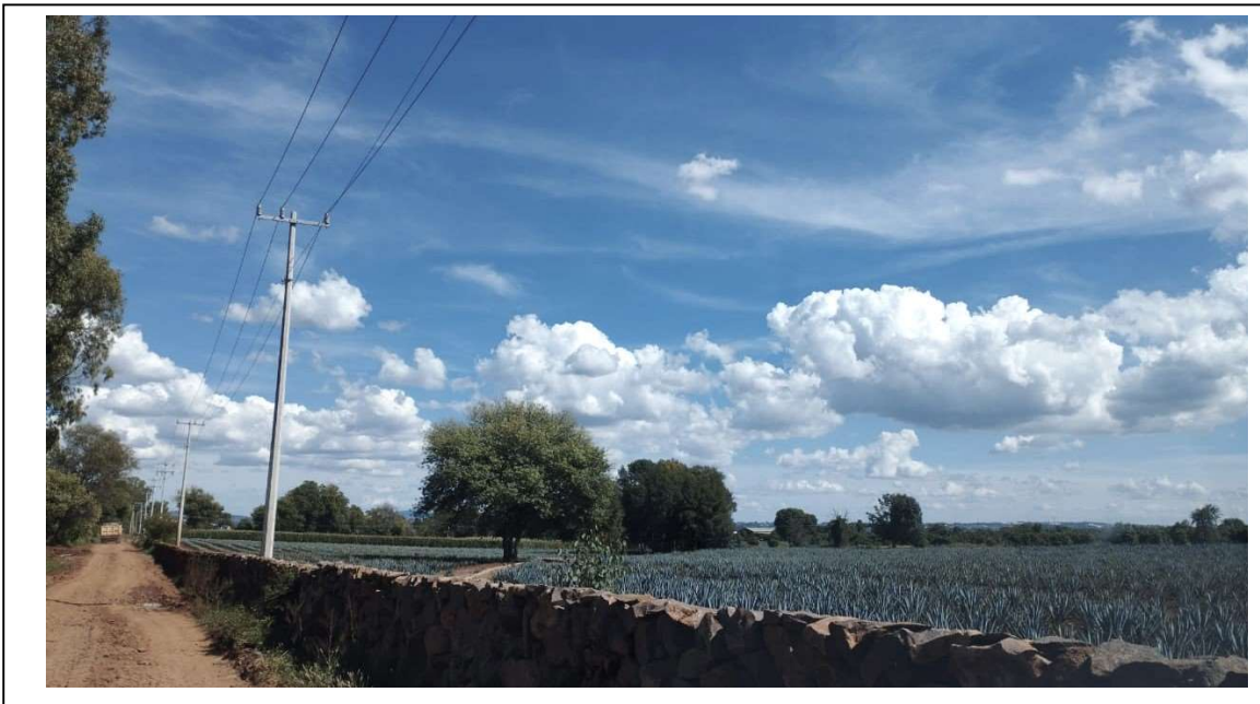
Fig. 45- fotografía de la línea de electricidad e, Fotografía propia 2022.
